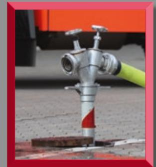
Unterflurhydrant mit Standrohr
